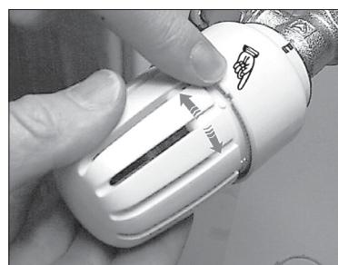
Sada tuljac za blokadu bez naprave povući u smjeru ručnog kola sve dok se ne pokriju oznake na ručnom kolu i dok čujete da je tuljac uskočio u svoj položaj.
