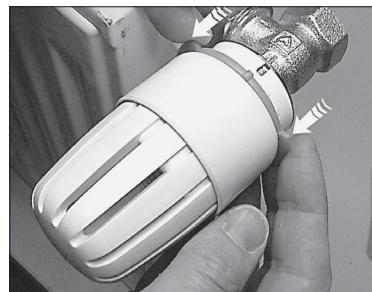
Tuljac za blokadu sad je deblokiran i može se gurnuti prema matici za pričvršćenje. Nakon toga su na ručnom kolu vidljive oznake namještanja. Naprava za deblokadu može se odstraniti.
