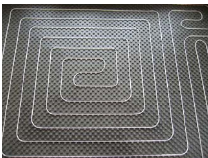
Bifilare Verlegung mit Noppenplatten
