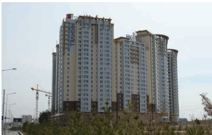
Жилой комплекс «HIGHVILL»
