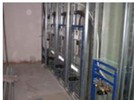
Linijaska urinalna instalacija u suvomontažnom zidu
