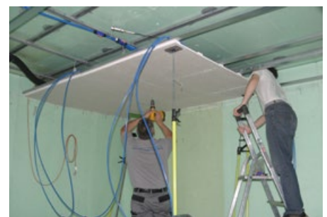
Die Deckenkühlung wird von UNIVERSA-Mitarbeitern montiert
