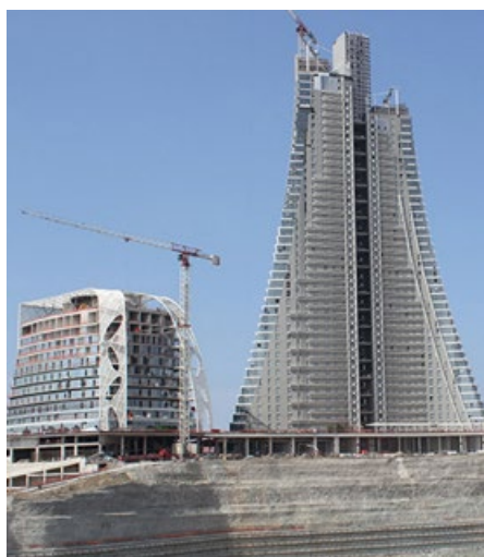
HERZ stattete das Istanbuler Sarphan Finance-Center mit Kombiventil-Volumenstromreglern, Differenzdruckreglern, geflanschten Durchgangs- und Strangreguliertventilen aus
