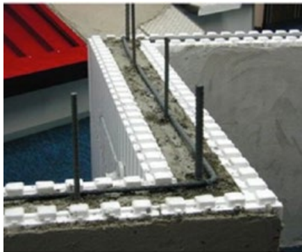
Die Schalungssteine sind fixer Bestandteil der fertigen Gebäudekonstruktion
