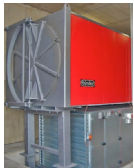
Der Luftwärmetaucher mit 1.650 Kilowatt Leistung wird zur Trocknung landwirtschaftlicher Güter eingesetzt
