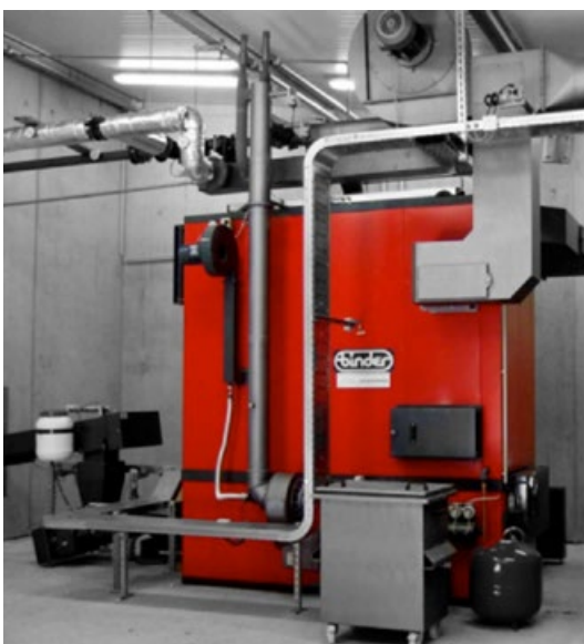
Mit der 500-Kilowatt-Anlage können Kunden rund 8.000 Quadratmeter Bürofläche beheizen
