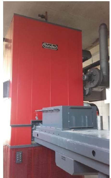
Die 1.650-Kilowatt-Anlage sorgt in einem rund 20.000 Quadratmeter großen Glashaus für Wärme
