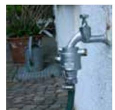
Eine Möglichkeit HERZ Systemtrenner mit selbständiger Frostschutzentleerung zu verwenden
