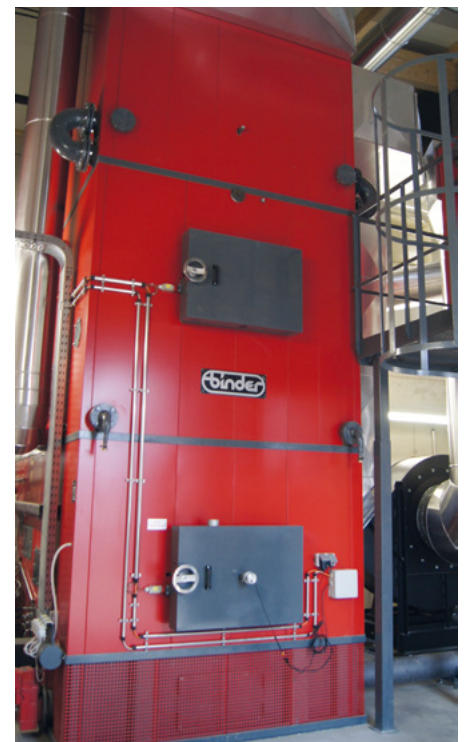
Der BINDER-Kessel hat eine Leistung von drei Megawatt
