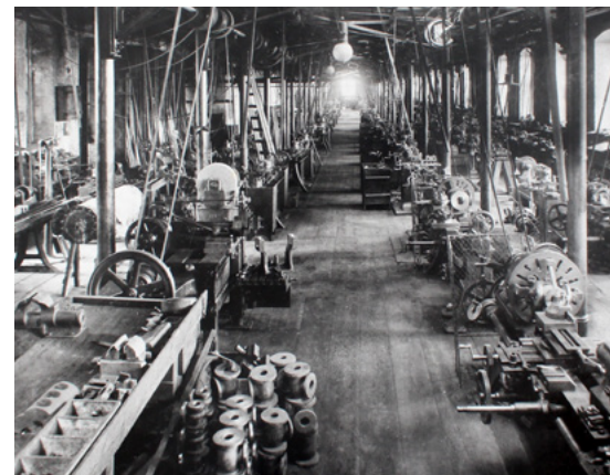
Zum Antreiben der Maschinen wurden Transmissionen verwendet
