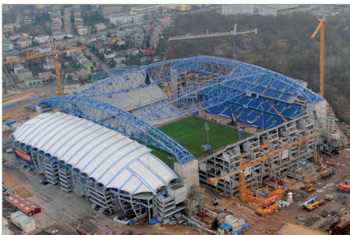
Das Stadion von Poznan/Posen während des Umbaus
