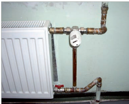
Sonderfall der senkrechten Einrohrheizung, hier war der Meister im Löten am Werk
