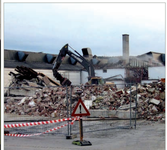
Die Abbrucharbeiten in vollem Gang
