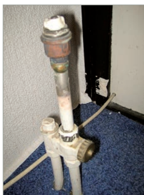
Chef, die Entlüftung funktioniert endlich
