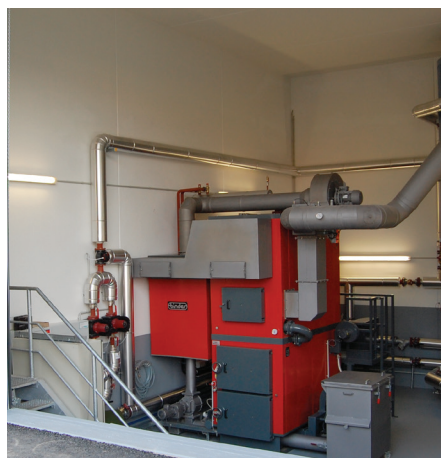
Die BINDER-Feuerungsanlage der ASFINAG in Lebring
