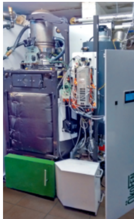
Kessel-Fernweh: ÖkoFen-Pelletskessel mit Stirlingmotor zur Stromerzeugung in Brügge – auch Belgien eignet sich als Ort für Pilotanlagen
