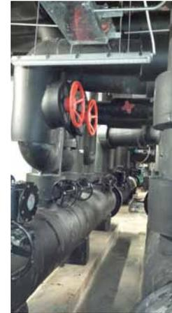
HERZ Strangregulierventile unterschiedlichster Größenordnung wurden für die Kälteanlage im neuen Parlament installiert.
