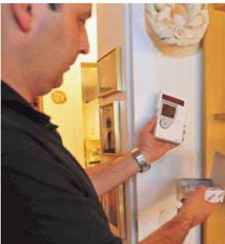
Selbstlernende Einzelraumregelungen mit Präsenzerkennung, die das Nutzerverhalten als Einsparungspotenzial erschließen, werden in der EnEV-Energiebilanzierung für KfW-Effizienzhäuser anerkannt. Der nach DIN V 4701-10 ermittelte Heizwärmebedarf des Gebäudes kann laut Kieback und Peter pauschal um 5% reduziert werden. Bild: Kieback und Peter
