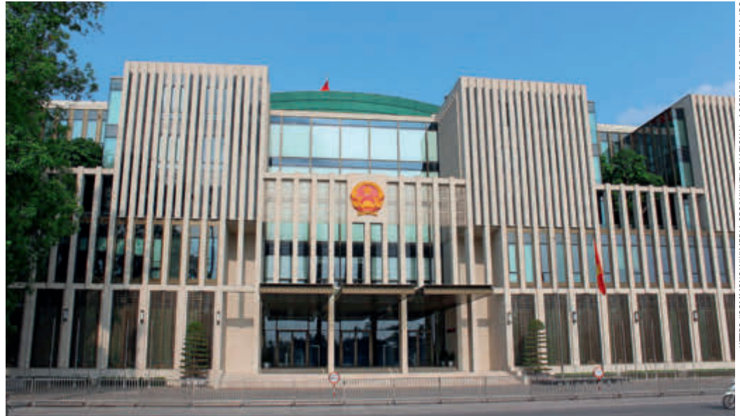
Das deutsche Architekturbüro Gerkan, Marg und Partner plante das Großprojekt „Parlament Hanoi“ mit Herz-Strangregulierventilen. Diese bieten ein Maximum in puncto Einfachheit und Geschwindigkeit beim statischen Abgleich.
