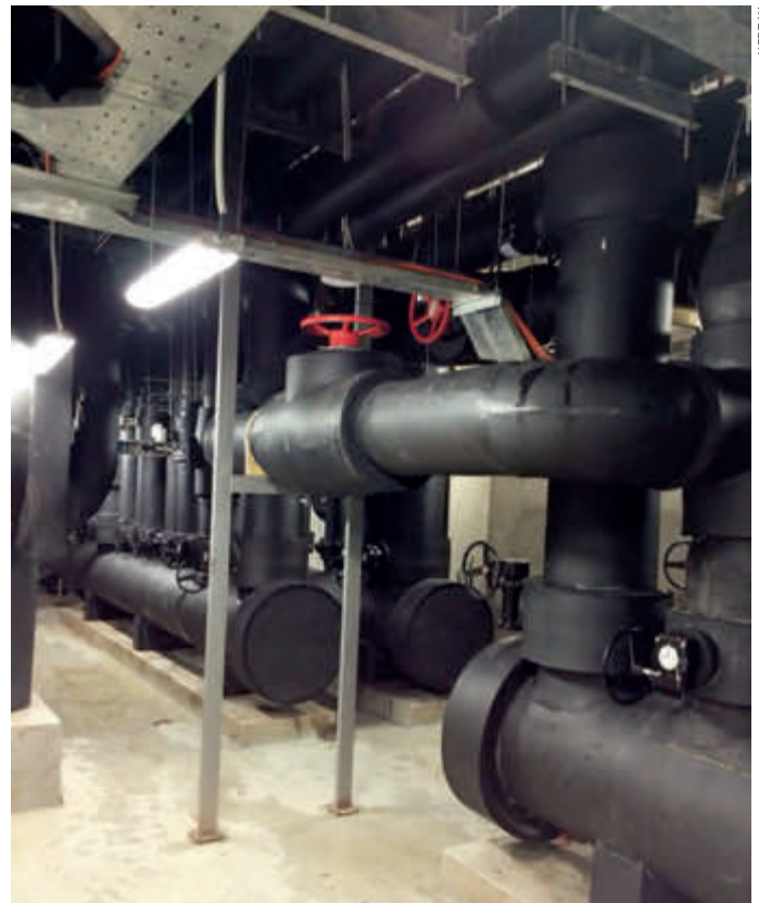
Rechts: Die Kaltwasseranlage zur Klimatisierung des neuen Parlaments in der vietnamesischen Hauptstadt.
