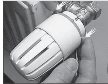
Die Verriegelungshülse ③ ist jetzt entriegelt und kann Richtung Befestigungsmutter verschoben werden, dabei werden die Einstellmarkierungen des Handrades sichtbar. Das Entriegelungswerkzeug kann entfernt werden.
