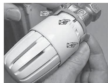
Entriegelungswerkzeug bis Anschlag in den Schlitz zwischen Rippenring ② und Verriegelungshülse ③ einschieben.
