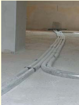
Beispiel: Anschluss HERZ-Unterputzverteiler
