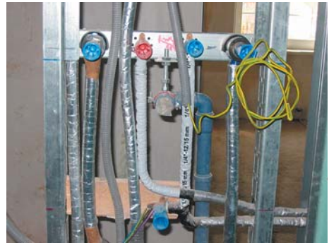
Beispiel: Zwischenwandinstallation im Sanitärbereich mit HERZ-Rohren
