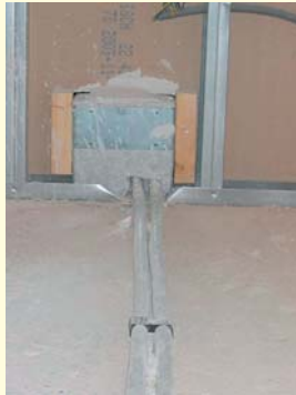
Beispiel: Anschluss HERZ-Unterputzverteiler
