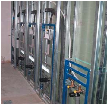
Beispiel: Zwischenwandinstallation im Sanitärbereich mit HERZ-Rohren
