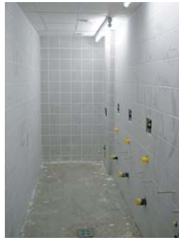
Beispiel: Zwischenwandinstallation im Sanitärbereich mit HERZ-Rohren
