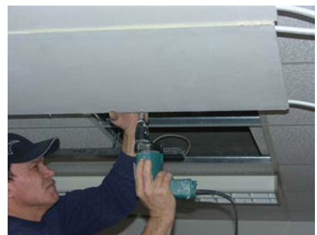
Montage Kühldecke
