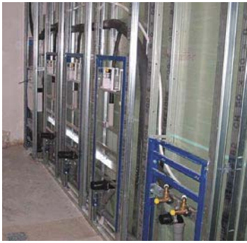
Primer: Sanitarna instalacija u pregradnim zidovima sa HERZ-cevima
