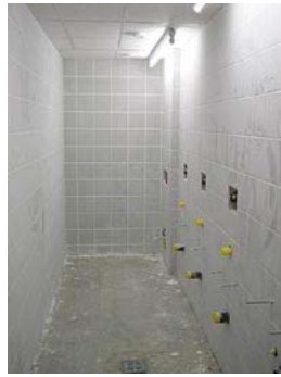
Primer: Sanitarna instalacija u pregradnim zidovima sa HERZ-cevima
