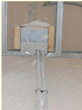
Primer: Priključivanje HERZ-razdelnika ispod maltera
