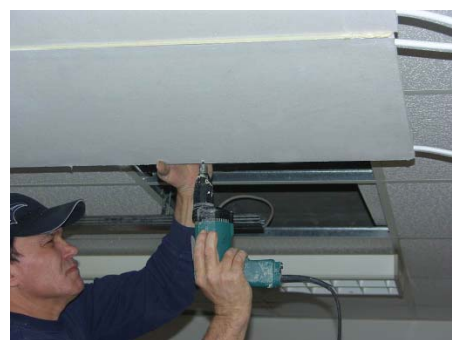
Montaža plafonskog hlađenja
