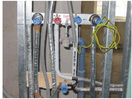
Primer: Sanitarna instalacija u pregradnim zidovima sa HERZ-cevima
