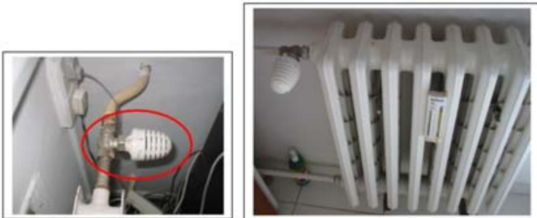
**Slika 24. HERZ termostatski ventil sa ugrađenom termostatskom glavom**
