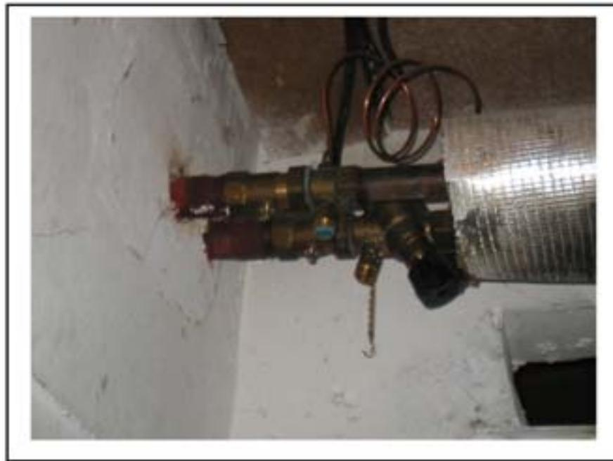
**Slika 26. Ugrađeni HERZ regulator diferencijalnog pritiska i protoka**
