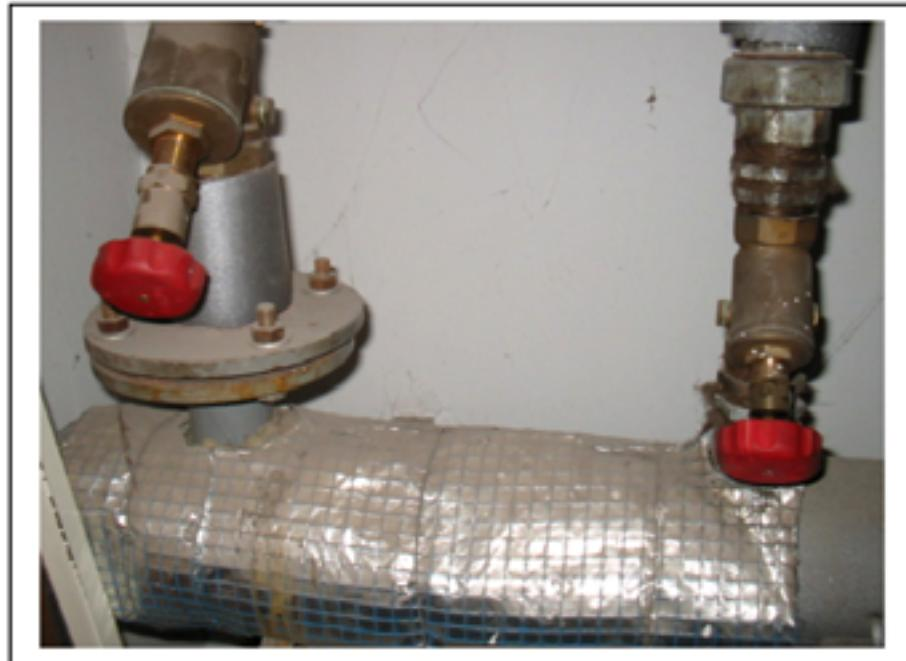
**Slika 28. Ugrađeni HERZ ventil za regulaciju usposkih vodova**
