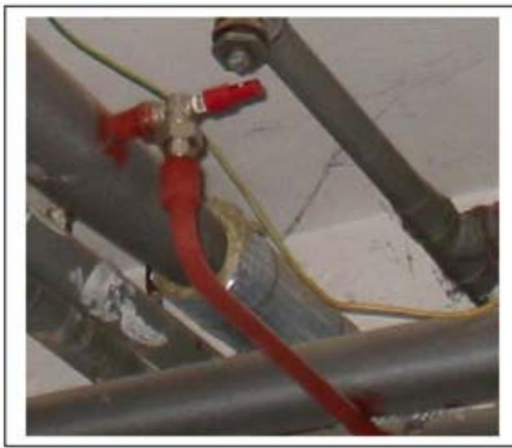
**Slika 27. Ugrađeni HERZ prestrujni ventil**
