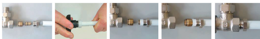
Pritezanje navojnog priključka
