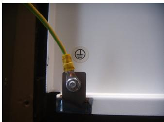
Bei Servicearbeiten kann die Schutzleiterverbindung der Fronttüre gelöst werden. Diese Verbindung muss nach Servicearbeiten unbedingt wieder hergestellt werden.
