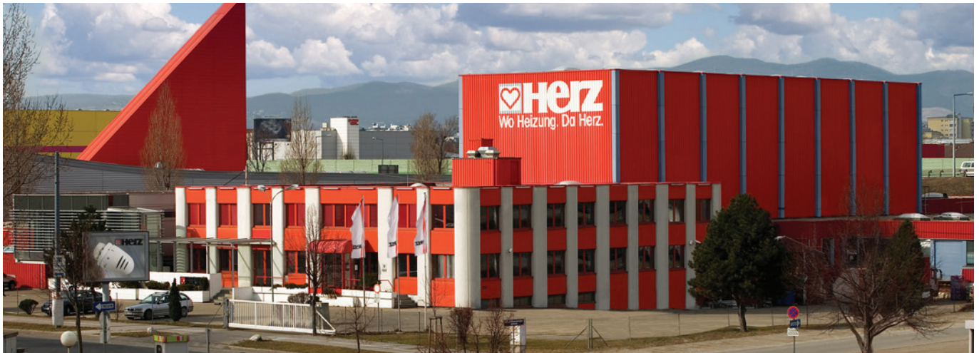
HERZ Armaturen Zentrale, Wien
