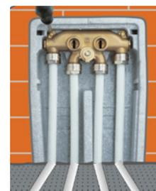
4. In diesen Wandschlitz wird der Unterputzkasten direkt auf den Rohfußboden gestellt, eingerichtet und fixiert. Nun kann die Anlage gefüllt und eine Druckprobe durchgeführt werden.
