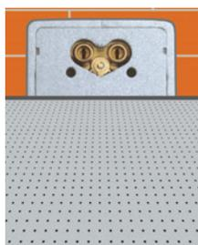
5. Der Kastendeckel wird durch Absägen der Höhe des fertigen Fußbodens angepasst und der Kasten verschlossen. Anschließend kann der Estrich eingebracht werden.
