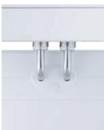
10. Abschliessend kann die HERZ-Abdeckrosette (1 3030 50) in der erforderlichen Abmessung abgelängt und angebracht werden.
