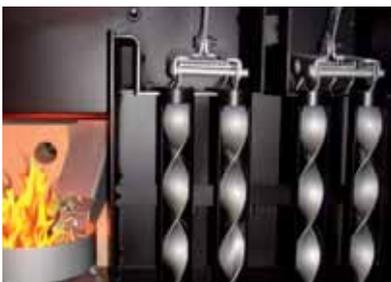
Die Wärmetauscherflächen werden
