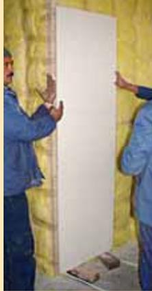
Die erste Heizplatte wird angesetzt.
