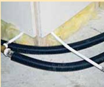
Die Rohre werden mit Pressfittings verbunden und verpresst. Vor der Einbringung des Estrichs sind die Rohrverbindungen gegen Feuchtigkeit zu isolieren.
