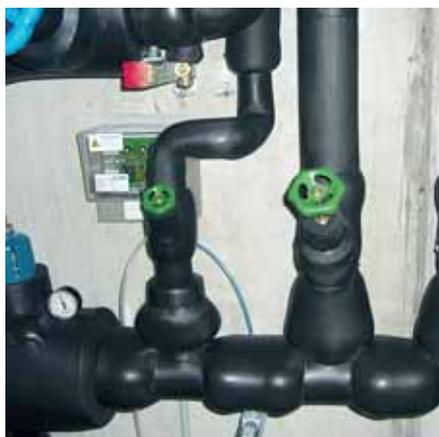
Die Kaltwasserleitungen wurden diffusionsdicht isoliert. Dadurch wird Kondensatbildung an den Oberflächen vermieden.
