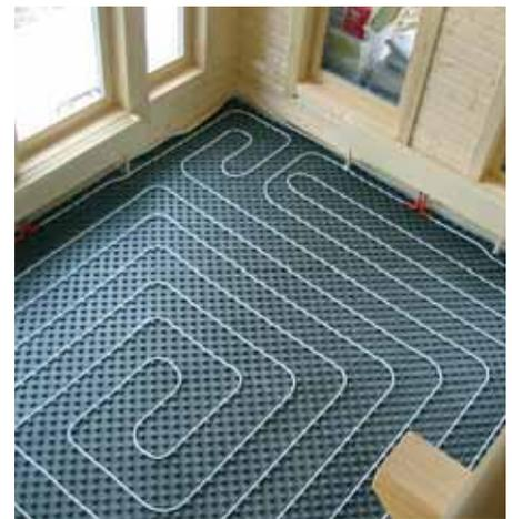
Die HERZ-Noppenplatten werden mit einer Überlappung von 50 mm verlegt.
