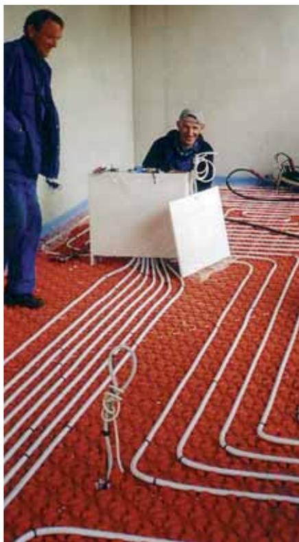
druckt, das die Montage der HERZ-Heizrohre mittels Tackernadeln erleichtert. Durch die gewebeverstärkte Oberfläche ist ein Ausreißen der Tackernadeln nicht möglich. Die Haltekraft der HERZ-Tackernadeln wird durch schräges Eindringen der Nadel noch gesteigert. Die Nadeln werden in Verpackungseinheiten zu je 30 Stück ausgeliefert und mit dem für diese Tackernadeln geeigneten HERZ-Tacker- setgerät eingedrückt.
