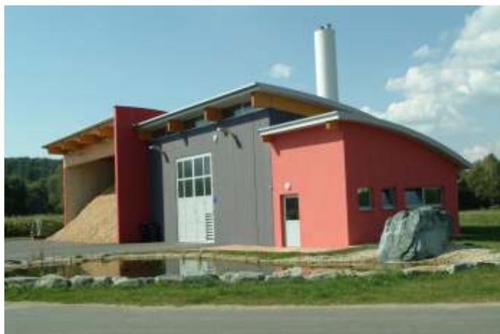
Das Biomasseheizkraftwerk St. Martin ist mit zwei HERZ-BioMatic Kesseln für den Brennstoff Hackschnitzel ausgestattet. Seit Dezember 2005 versorgt die Anlage gut 70 % der Haushalte der südburgenländischen Gemeinde.
