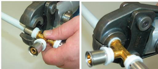
Mit Pressgerät oder Handpresszange Verpressung durchführen. Röhre müssen spannungsfrei sein. Der Pressvorgang ist beendet wenn der vollständige Backenschluss erreicht ist.
