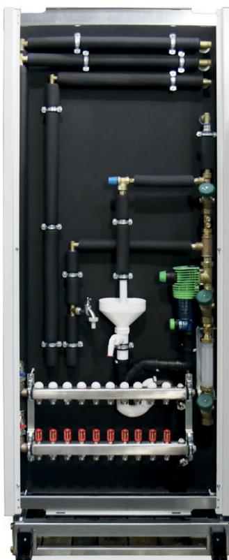
Izrazito lako održavanje i različite varijante postavljanja – prilagođavanje individualnim okolnostima – čini Hydrotower univerzalno primjenjivim. Čak i pri integriranom provjetravanju stana i korištenju kišnice SA-Hydrotower zauzima tek 78 x 42 x 185 cm prostora.
