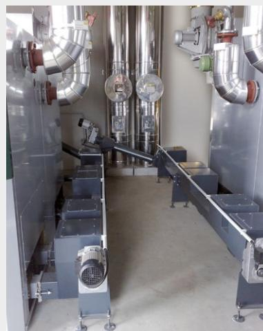
Slika: Spajanje spremnika pepela preko pužnog sustava kod jednog kaskadnog slučaja
