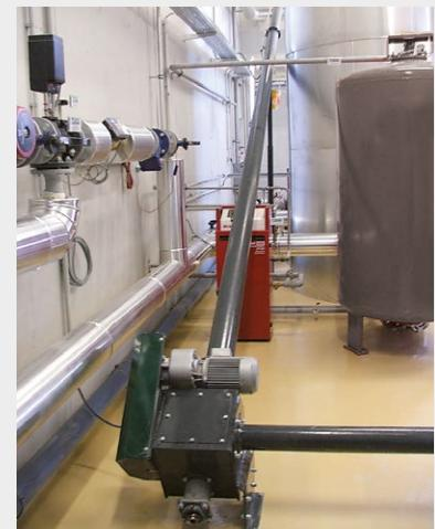
Slika: Transport pepela iz 2 HERZ-ova postrojenja pomoću uspinjućeg transportnog puža na visinu od 4 m u spremnik pepela od 2 m<sup>3</sup> izvan kotlovnice.
