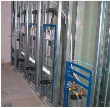
Primjer: Sanitarna instalacija u montažnom zidu HERZ- cijevima
