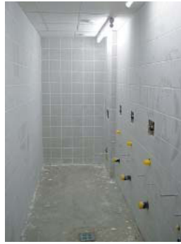
Primjer: Sanitarna instalacija u montažnom zidu HERZ- cijevima
