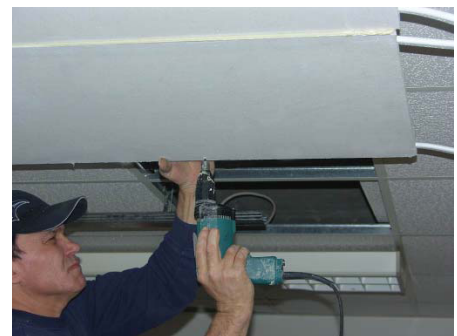
Montaža stropnog hlađenja
