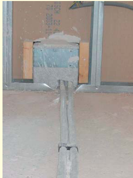
Primjer: Priključak HERZ-podžbuknog razdjelnika
