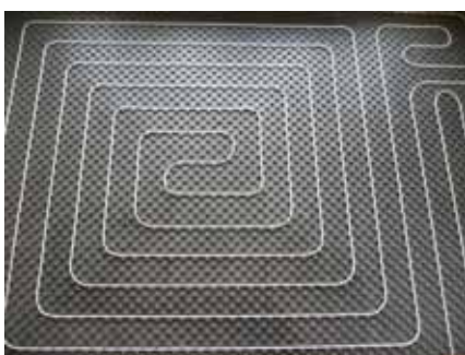
Dvojcijevno polaganje raster pločama
