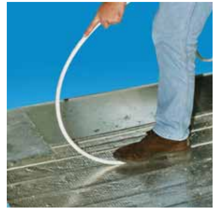
Utiskivanje cijevi za grijanje
