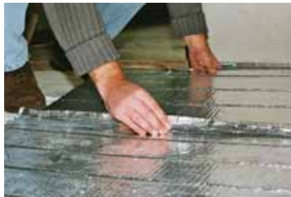
Postavljanje višesteznih ploča i preklapanje ljepljive folije
