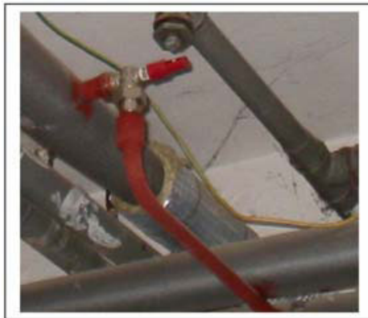
Slika 27. Ugrađeni HERZ prestrujni ventil
