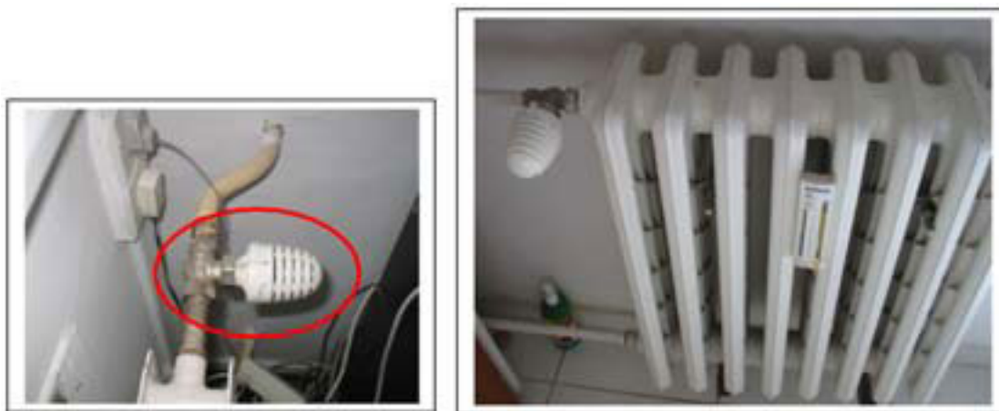
Slika 24. HERZ termostatski ventil s ugrađenom termostatskom glavom
