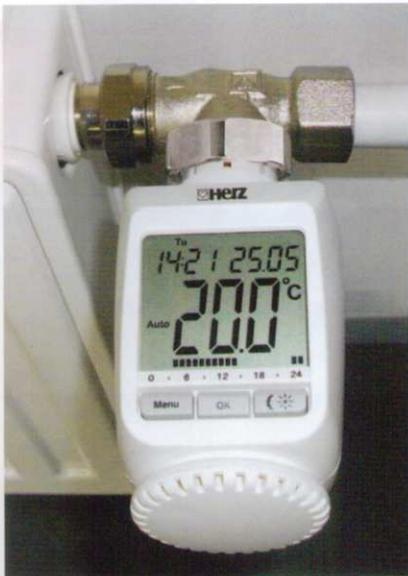
Nach den Grundeinstellungen, wie Datum und Uhrzeit, wird der elektronische Thermostatkopf am Ventil montiert. Er adaptiert sich von selbst mit dem Thermostatventil, sobald „OK“ gedrückt wird.
